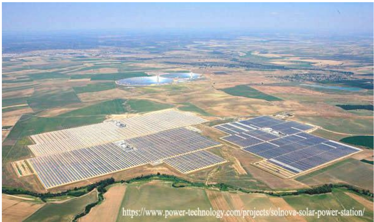
Vista aérea de varias plantas solares.
